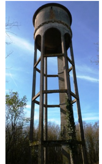
Château d'eau – D424
